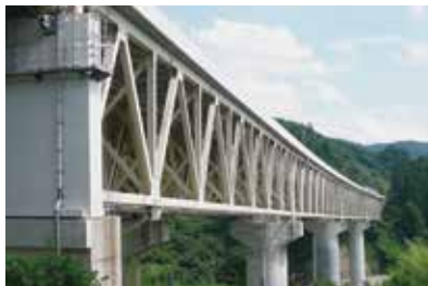
▲ NEXCO西日本 小坂部川橋 ▲
