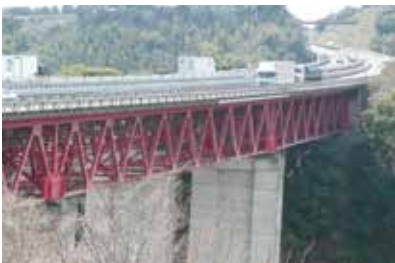
▲ NEXCO中日本 柳沢橋 ▲
