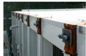
高級モジュールハウス ユニットのジョイント
