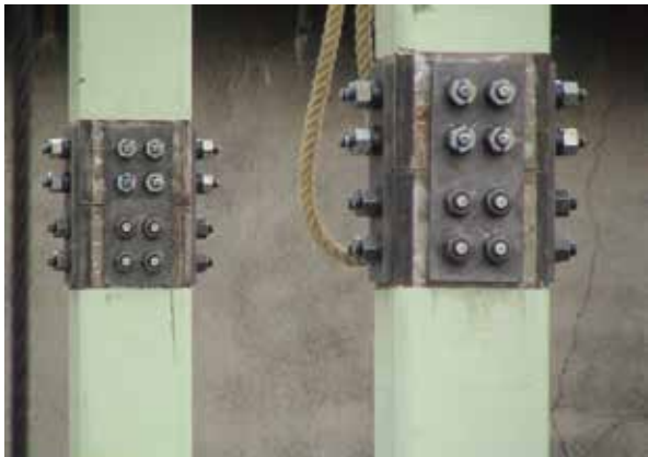
コージェネレーション架台新築
