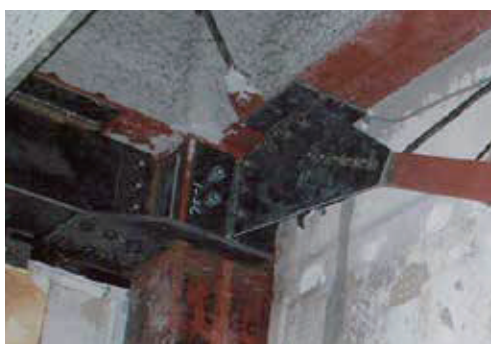
斜材取付・ブレースPL取付
