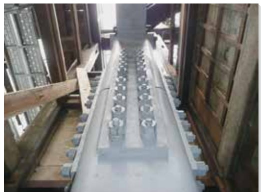
国指定重要文化財 耐震工事
