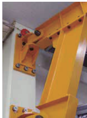
ジブクレーン取付
