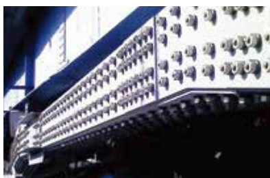
▲ トラス橋耐震補強 ▲
