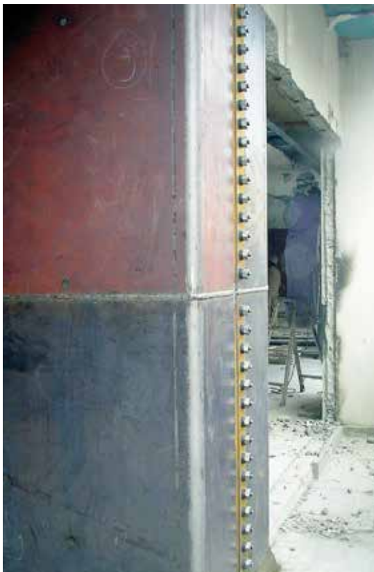
RC柱 鋼板巻耐震工事
