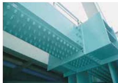
▲ 東京都 浮間橋 ▲
