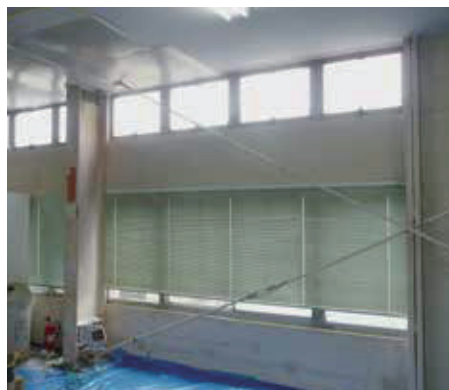
T工場食堂耐震
