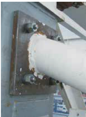
O社新築庇取付
