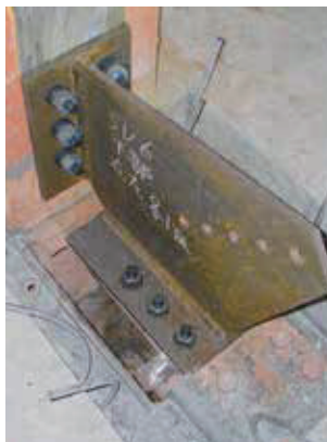
病院耐震増築工事
