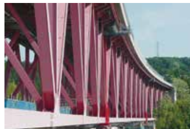
▲ NEXCO東日本 片品川橋 ▲
