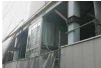
エレベーター設置 補強
